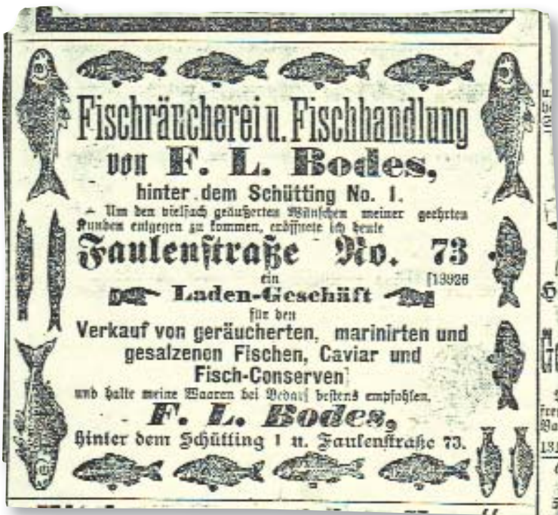
■ Anzeige zur Eröffnung der Filiale in der Faulenstraße 73, 1882
